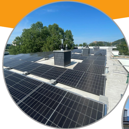
◀ Flachdach zweier Mehrfamilienhäuser 29,92 KW/ Wechselrichter im PV-Shelter
